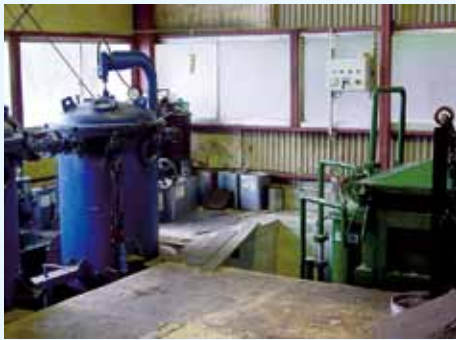
真空タンク (Vacuum Tank)
